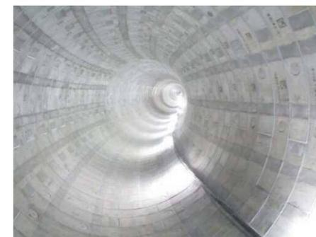
下水道管の下に更に大きな増補管を作り、下水道管から溢れる雨水を増補管で受け止めます。
