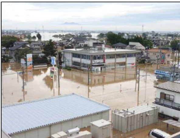
茨城県 常総市役所 平成 27 年関東・東北豪雨で被災
