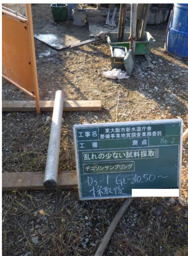
デニソンサンプリング 2D-1 (GL-30.50~31.20m) 採取後
