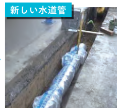
新しい水道管
